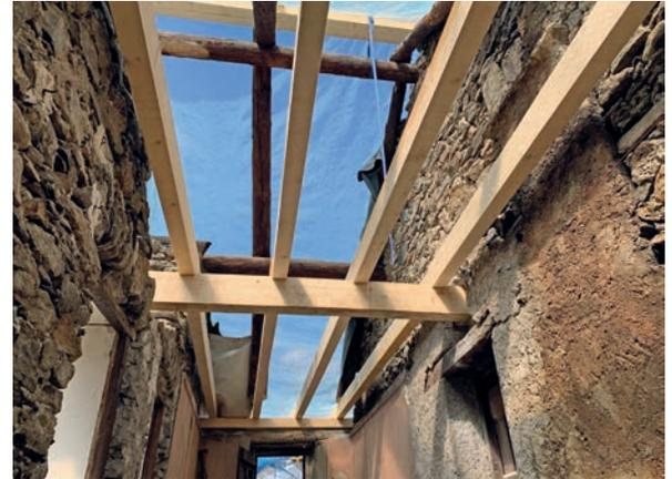
**Der alte Dachstuhl sollte im Inneren erhalten und sichtbar bleiben, sodass im Rahmen der Sanierung eine aufwendige Dach-über-Dach-Lösung umgesetzt wurde.**
